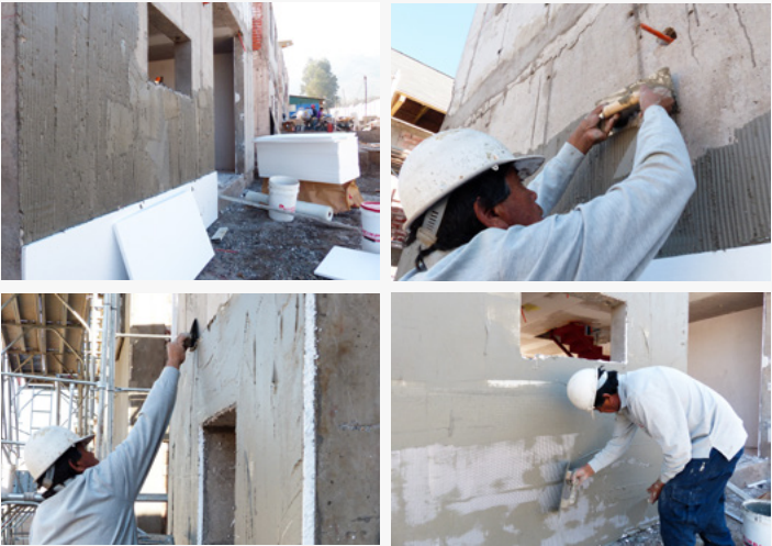
Proceso de instalación sistema EIFS Reimpas.
