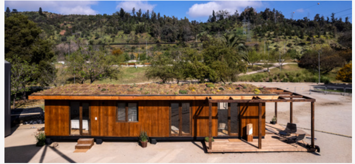
Vista aérea de MAT Vivienda Modular de Ayma lanzada en SDLM 2025, con PaillePanel, Rekopanel, SIP Paillepanel y techos verdes.
